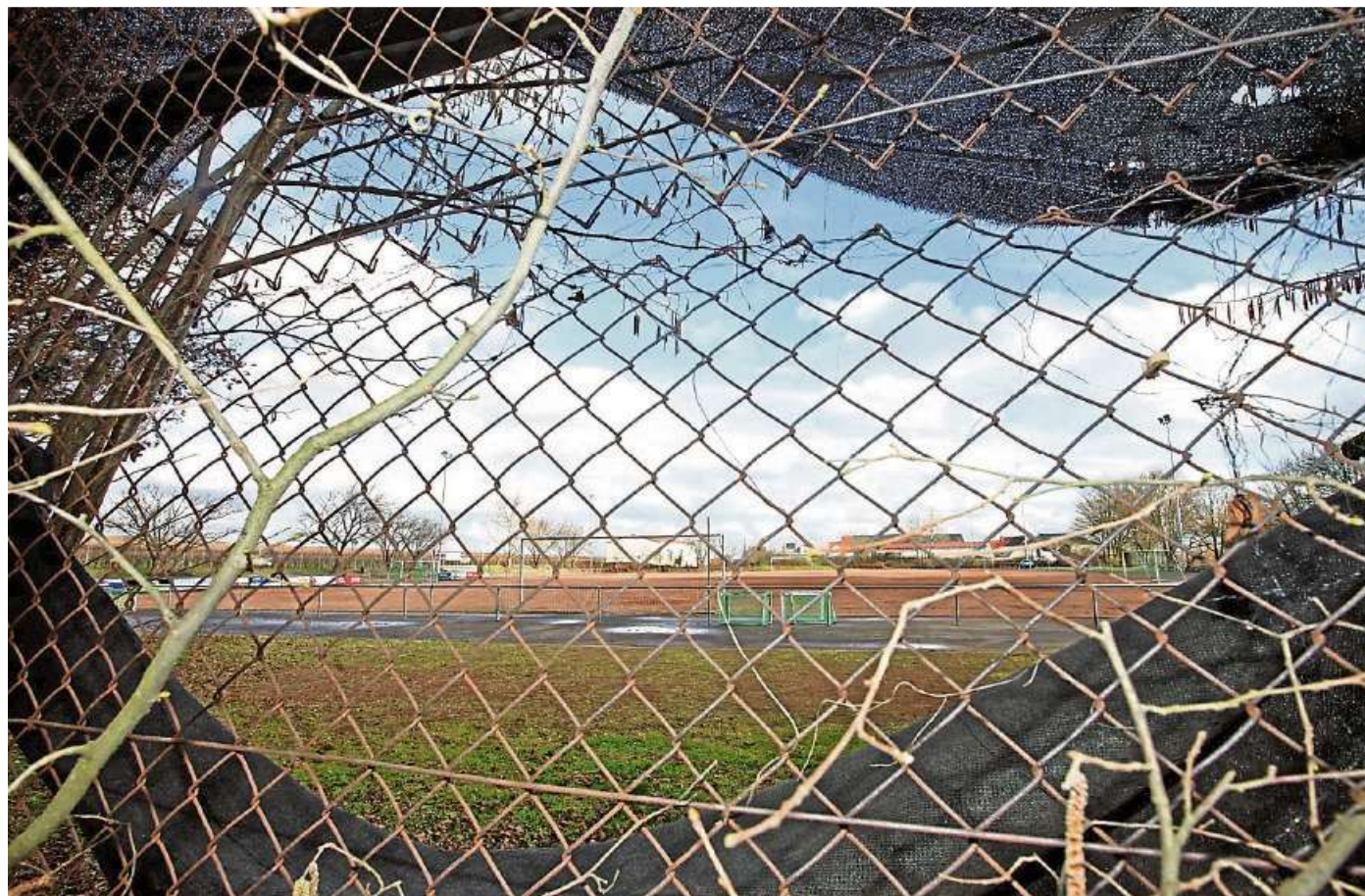
Der Hartplatz in Lörzweiler soll zu einem Kunstrasenplatz umgebaut werden.
